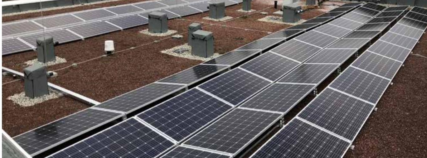
Envesta Projekt Dachfläche: Die auf dem Dach errichtete Photovoltaikanlage versorgt nicht nur 137 Wohneinheiten mit Energie, sondern verringert auch die CO2 Emission um 125.000 kg pro Jahr.
