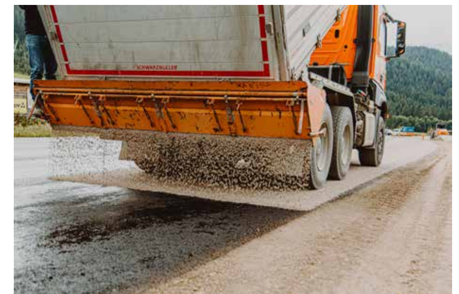
Entscheidend für die hohe und gleichmäßige Qualität der hydraulischen Tragschichte ist wie beim Betonieren der Verdunstungsschutz, der nach der Endverdichtung aufgetragen wird. Dieser wird unsererseits mittels Bitumenemulsion ausgeführt und wird für den mechanischen Schutz mittels Splitt abgestreut. Die Tragschichte kann bis zum Asphaltieren befahren werden. Der Verdunstungsschutz fungiert auch als Haftkleber für den späteren bituminösen Belag. Beide Schichten sind also verklebt und wirken als Trägerpaket.
