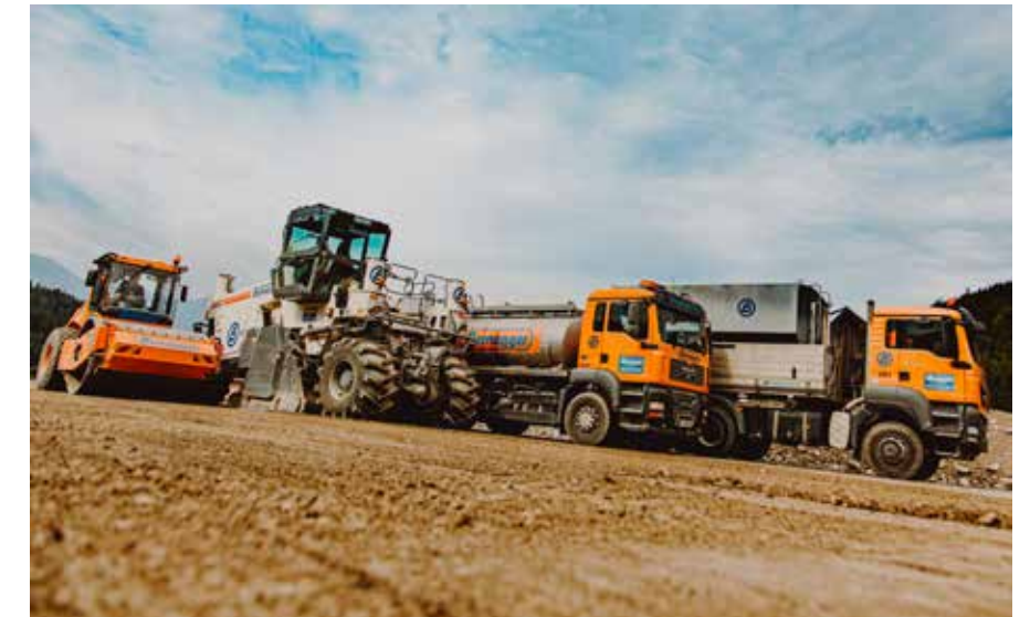
Der moderne Recyclingzug besteht aus Zementstreu- und Wasserwagen, leistungsstarker Recyclingfräse und moderner Verdichtungswalze (13 to) mit integrierter Verdichtungskontrolle und GPS-Aufzeichnung
